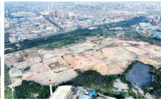
溪头高端装备智造中心项目现场
