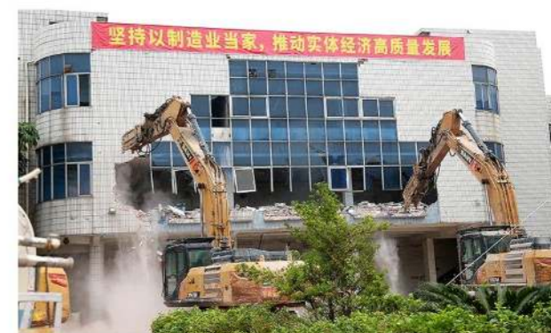
▲ 厚街溪头项目拆除启动仪式
